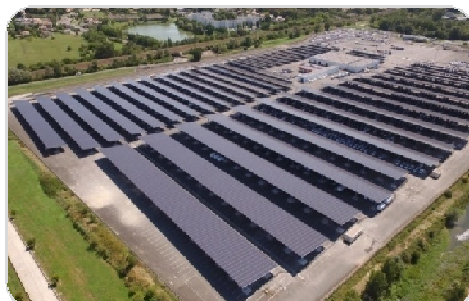
13.5MW 車棚屋頂 Bassens, 法國
