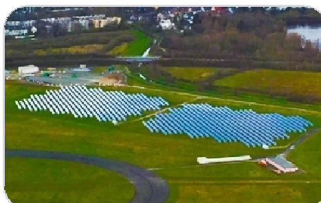
2MW 地面型 Dusseldorf Airport, 德國
