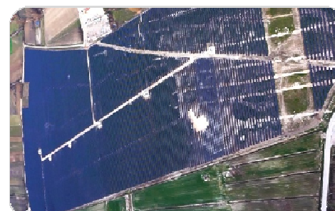
20MW 地面型, Celano, 義大利
